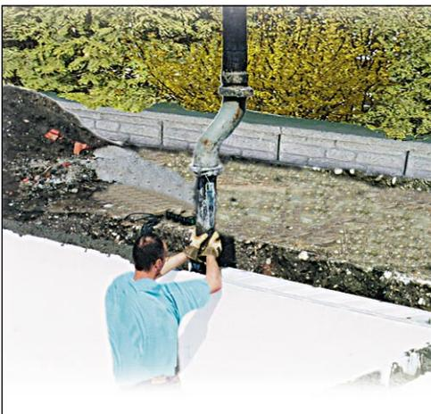
Beim Befüllen der Schalsteine mit Fertigbeton unbedingt Fallbremse verwenden (bei Betonbestellung angeben).
